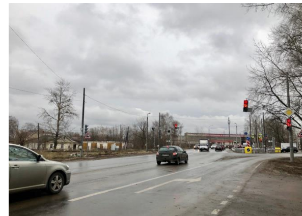
Реконструкция транспортной развязки на пересечении Стеклозаводского шоссе
