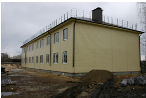
Строительство жилого дома в пос. Большое Пикино
