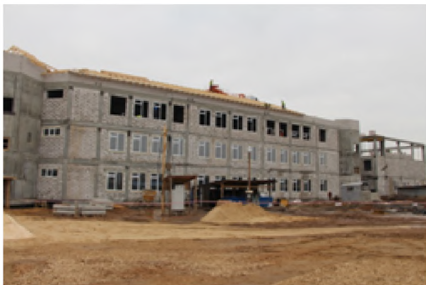
Начало строительства школы на 1 000 мест в микрорайоне «Красная горка»
