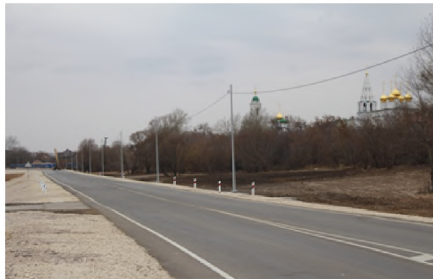
Завершение строительства объездной дороги
